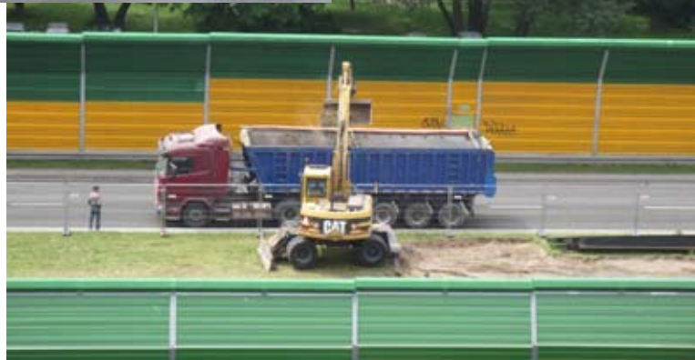
Zdjęcie z przyszłej wieży naszego kościoła
